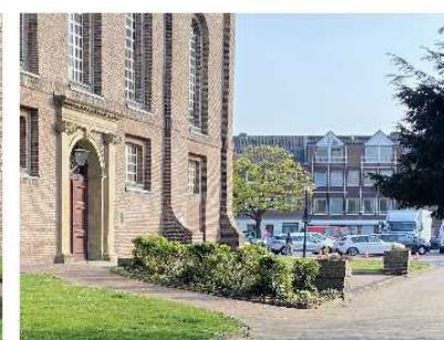
Rampe am Haupteingang
