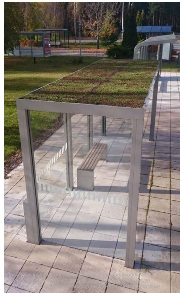
Wartehalle mit Gründach
